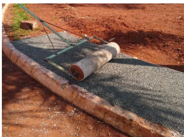
Figura 17 – Emprego do rolo compactador construído com material reciclado.
