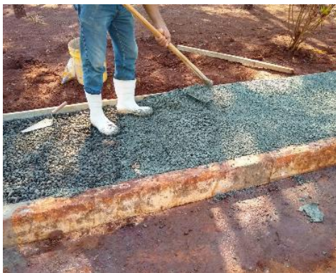
Figura 16 – Aplicação do concreto permeável nos trechos selecionados.
